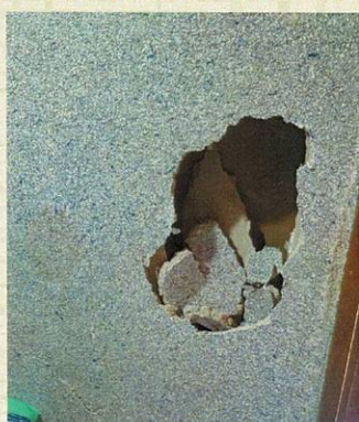
内壁に穴を開けた
